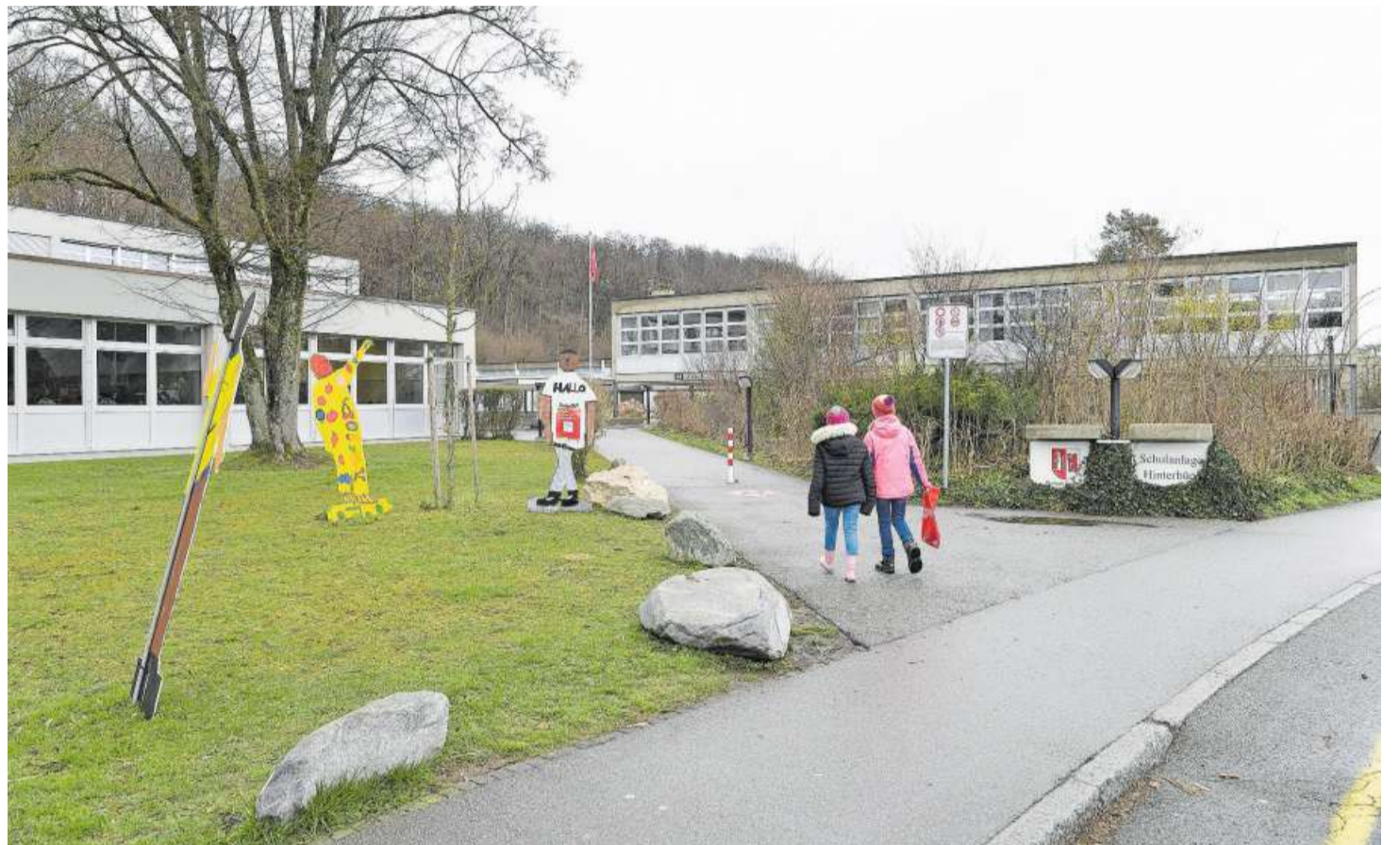
Das Schulhaus Hinterbüel soll in den nächsten Jahren saniert und erweitert werden. Die Frage beim Online-Podium drehte sich darum, ob die Steuern dafür erhöht werden müssen und ob die Oberstufe weiterhin selbstständig bleiben soll – ausser die Sek-P. Bild: Bruno Kissling
